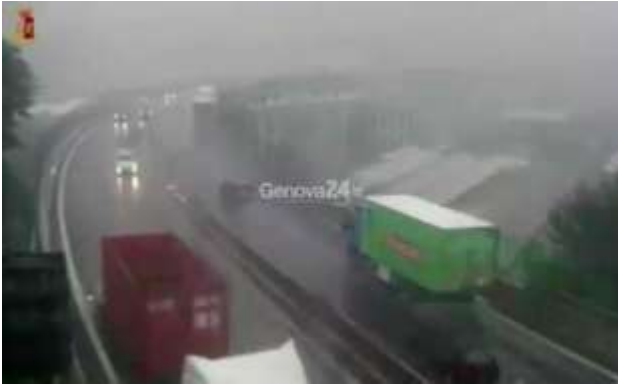
IL MOMENTO DEL CROLLO DI PONTE MORANDI A
